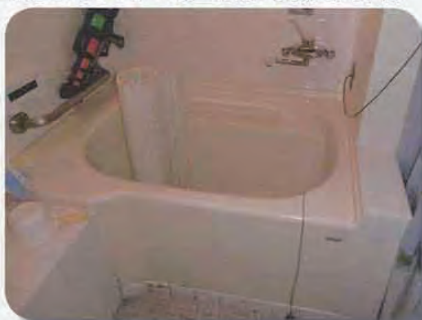
浴槽を跨ぎやすい浅型浴槽に交換した事例
