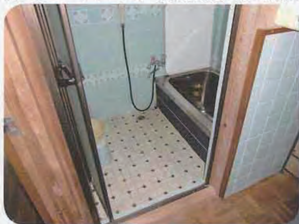
浴室をユニットバスに取替え洗面所との段差を無くした事例
