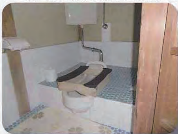
トイレ内の段差を解消し和便器を洋便器に変更した事例
