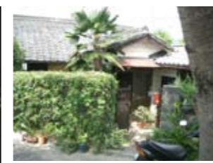
改善前写真② 道路から段差(-400mm)のある玄関を見る
