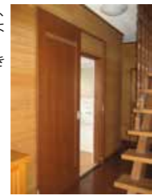
洗面所入り口の段差解消と開き勝手が悪かったドアを引き戸に
