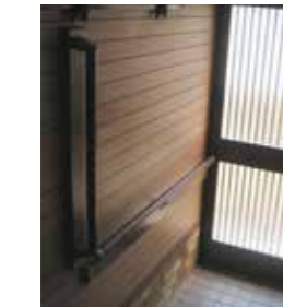
DKと玄関ホール間仕切りの段差解消
