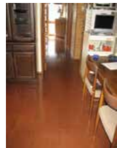
DKと玄関ホール間仕切りの段差解消
