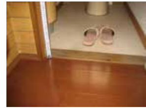
トイレ敷居の段差解消
