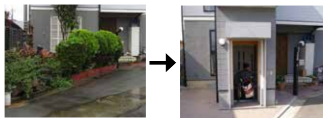
植込みを撤去しエレベーターを設置 (一人での外出も可能になった)
