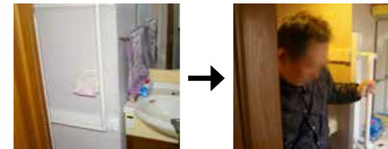
2階トイレの既存手摺りが体に近すぎたので、距離を確保した位置に付け替えることで立ち上がりやすくなった
