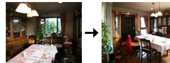
食堂の出窓位置にエレベーター出入口を設置
