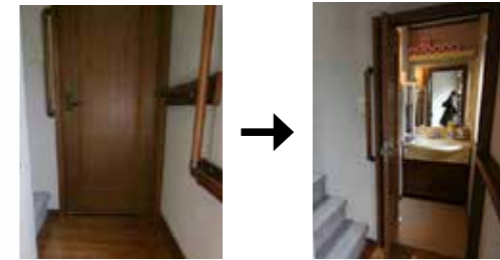
2階トイレのドアを釣り元を変えた折れ戸に変更
