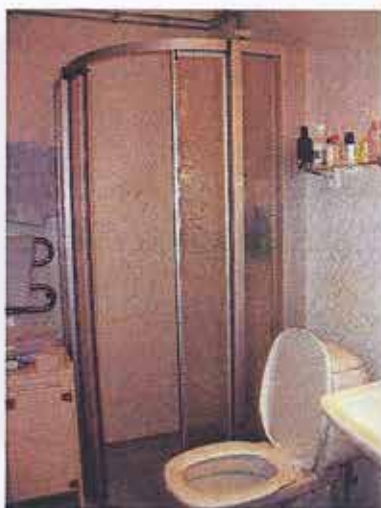
写真17 シャワー・便器
