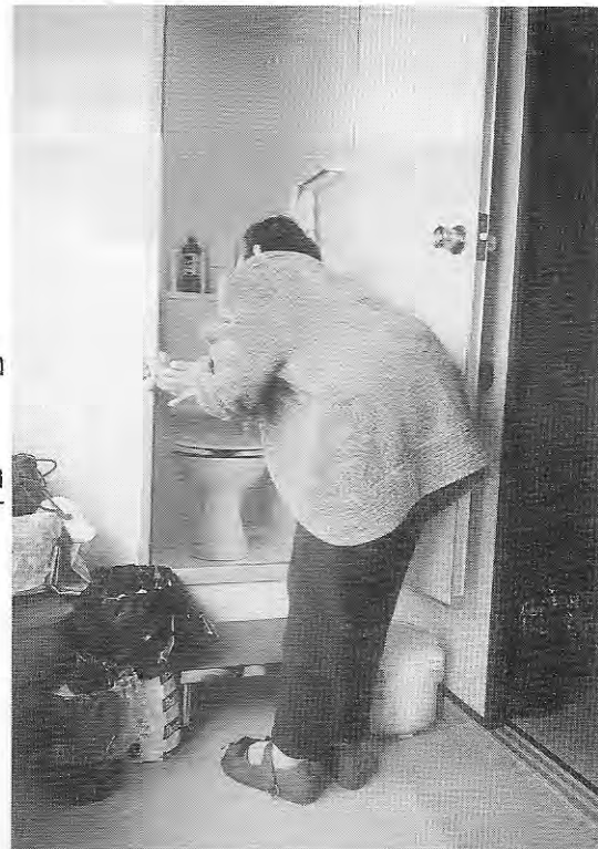
ユニットバス出入口：踏み台で改善（既製品） (B-2)
