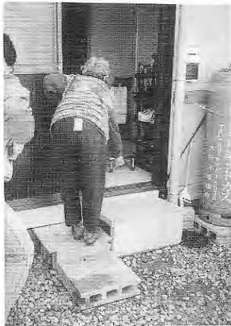
玄関の段差：3段に分割、折れ曲がり型（つかまる場所が必要）(A-6)
