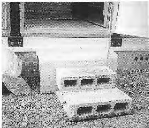
玄関の段差：3段に分割、ブロックとU字溝を使用 (A-15)
