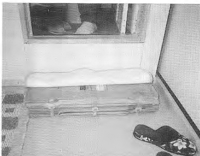
ユニットバス出入口：踏み台を居住者が工夫（左：ブロック）（右：段ボールを巻いてある）
