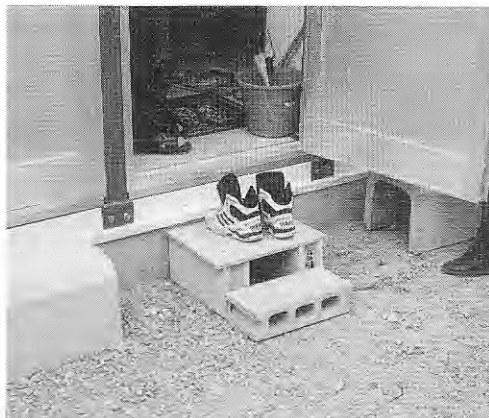
玄関の段差：2段に分割、コンパネと角材で固定 (A-4)
