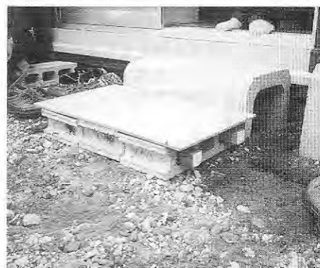
玄関の段差：2段に分割、ブロックと合板 (ブロックの中に固定の足を通してある) (A-5)
