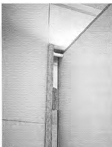
ドアストッパーが開口幅を狭めている例（B-5）
