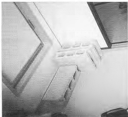
ユニットバス出入口：踏み台を居住者が工夫（左：ブロック）（右：段ボールを巻いてある）
