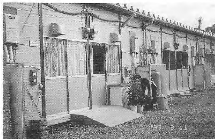
玄関のスロープ：行政対応、傾斜のきついスロープ（A-9）
