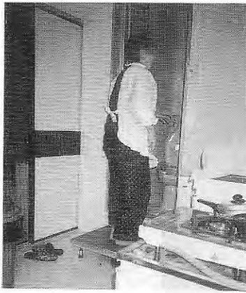
ユニットバス出入口：踏み台で改善（A：調整脚タイプ）(B-2)
