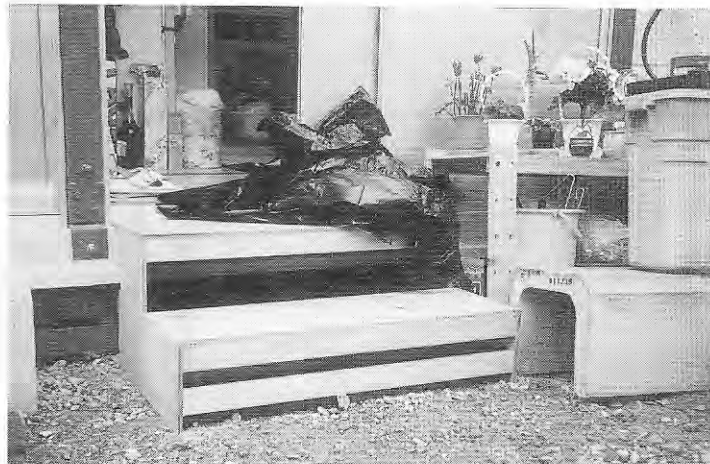
玄関の段差：2段に分割、サッシ際の処理（行政対応－芦屋）（A-14）
