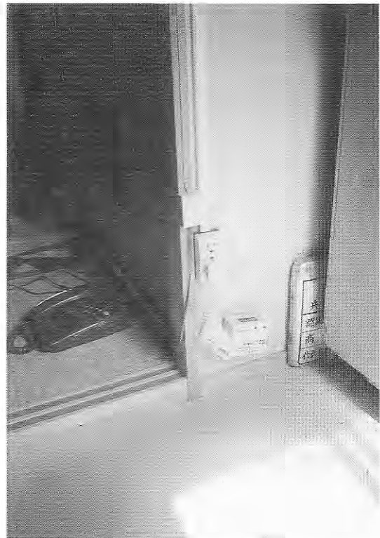
台所：ガス漏れ検知器の設置 (C-10)
