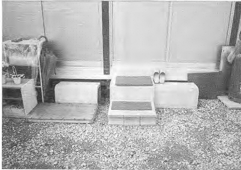
玄関の段差：ブロックにマット。木製の台とU字溝（共に居住者の工夫）（A-3）
