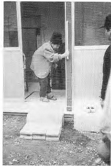
玄関見切縁：ステンレス製の方が木製より危険が少ない 玄関：手すり+2段に分割 (A-13)
