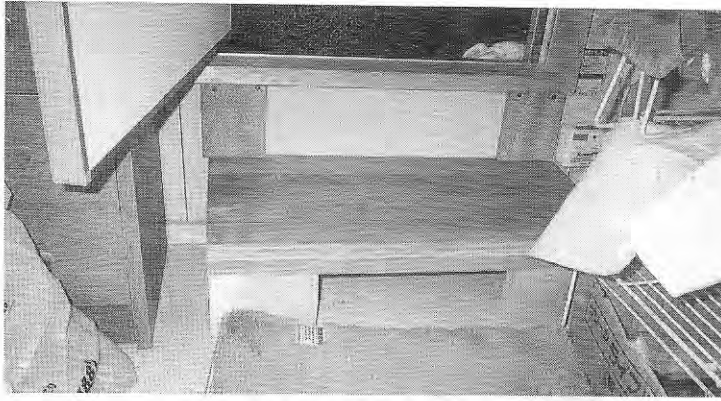
ユニットバス出入口：踏み台で改善（木製タイプ） (B-2)
