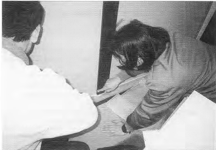
すき間に シーリングをする→
