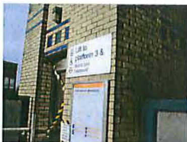
図 1.10 壊れたエレベーター
