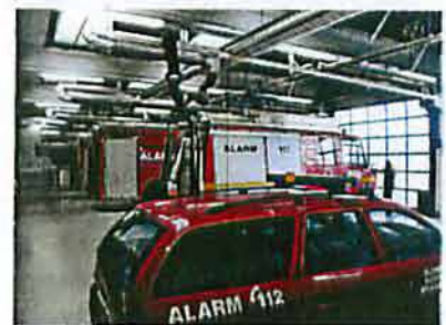
図 16.1 外観と消防署部分
