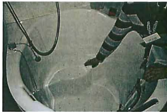
図 22.4 クエストデイセンターの給湯タイプの浴槽、 給排水の待ち時間があり評判は今ひとつかも
