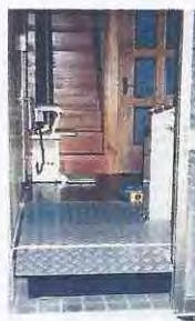
写真1 階段昇降機を使った例
