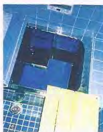
リウマチの人の浴室 関節を曲げにくいので、浴槽の外に腰かけ台を設けて、浴槽へ出入りしやすくしている。
