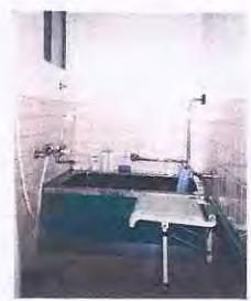
折り畳みベンチのある浴室 浴槽への出入りに腰かけ台がほしいが洗い場が狭いので、折り畳みベンチを壁にとり付けている。
