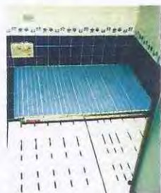
脊椎損傷者の浴室 腕で体を支えて移動するため、洗い場床と浴槽縁の高さをそろえ、浴槽へ出入りしやすくしている。
