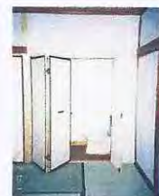
押入部分を改造した寝室内トイレの事例
